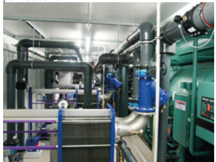
Vue d'un grand centre énergétique modulaire avec refroidisseur à absorption et échangeurs de chaleur pour la séparation du système.
