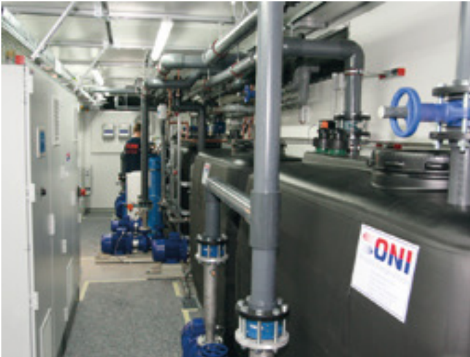
Phase d'assemblage final d'un centre énergétique modulaire pour alimenter un système de refroidissement à 2 circuits chez un transformateur de métaux.
