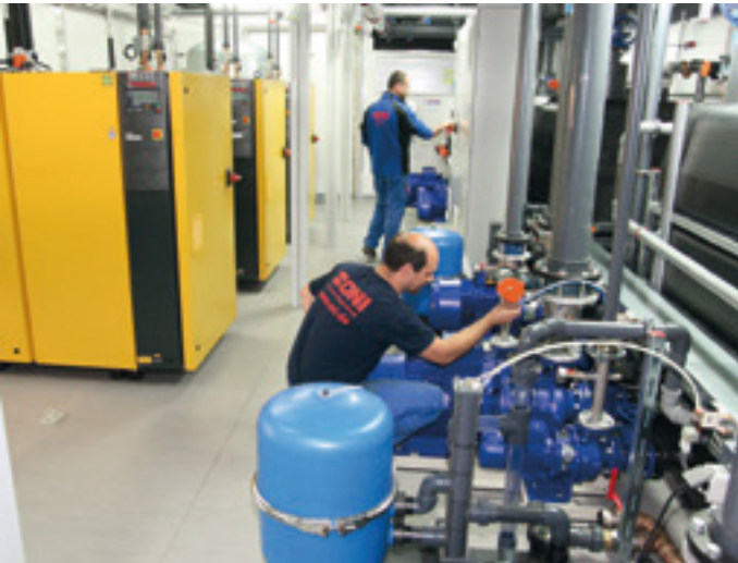
Système de refroidissement de conteneurs en combinaison avec un système central de génération d'air comprimé avec récupération de chaleur.
