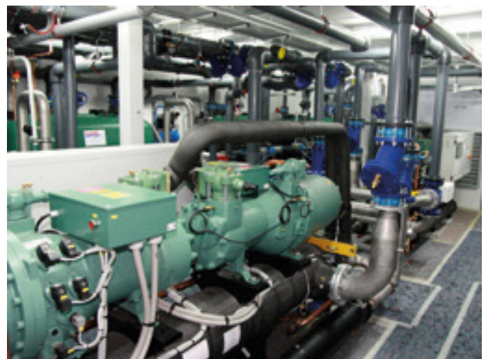
Vue d'un système de refroidissement de conteneurs optimisé en énergie avec un refroidisseur à eau.
