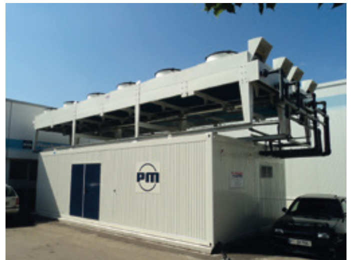
Exemple d'un centre énergétique modulaire à double conteneur chez un transformateur de matières plastiques dans le domaine du moulage par injection/de la technologie des systèmes.
